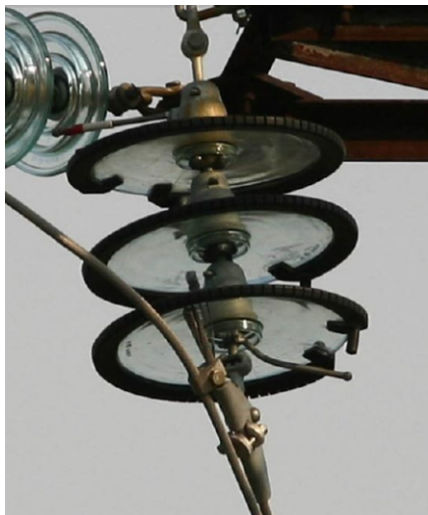
Рисунок 11 - Перекос зажима с касанием проводом ребра нижнего ИРМК
