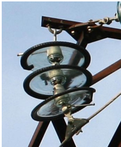
Рисунок 12 - Перекос ИРМК между собой более 5^\circ
